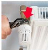
Après avoir dévisser un robinet, il vous faudra mesurer le **diamètre intérieur** de la vis de raccord du robinet ou la tête du corps thermostatique. Il existe 2 diamètres 28 mm ou 30 mm.
